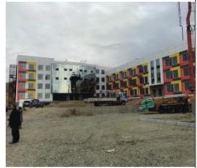
建設中の病院
